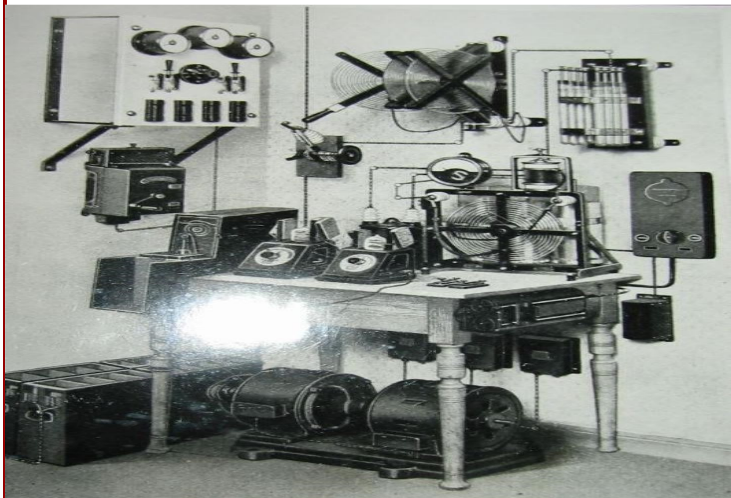
Oude Duitse Telefunken Schiffstation mit funkensender
